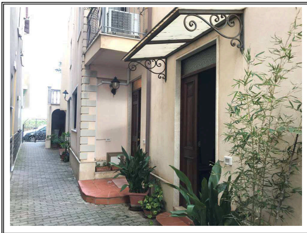
Foto N°19 (Appartamento Piano Terra Part. 105 Sub 7: Accesso Esterno)
