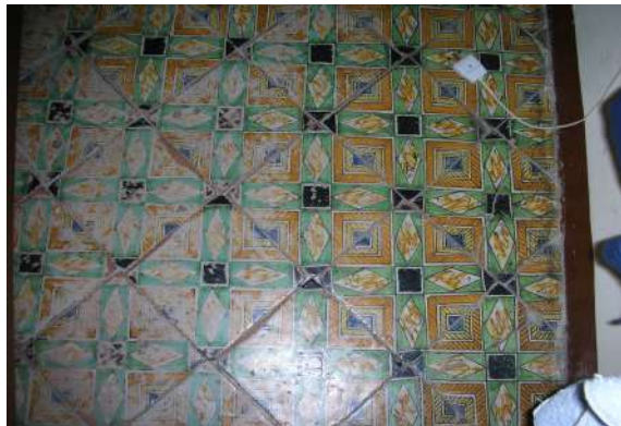
Particolare delle pavimentazioni
