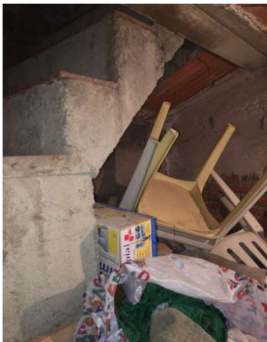
Scala interna per il soppalco sottotetto e l'altana
