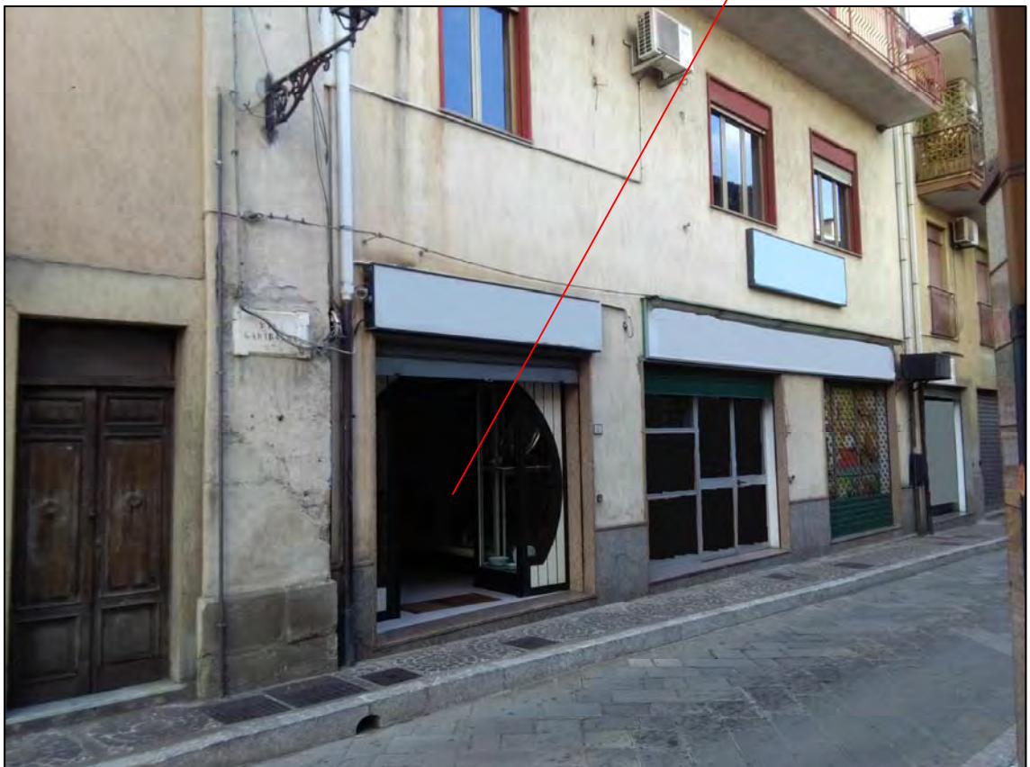
Foto 2 - Prospetto su Via Garibaldi
