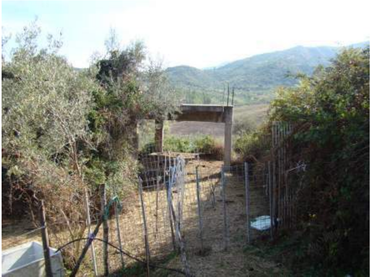
Figura 3 - Zona di accesso al momento del secondo sopralluogo del 30.10.2019
