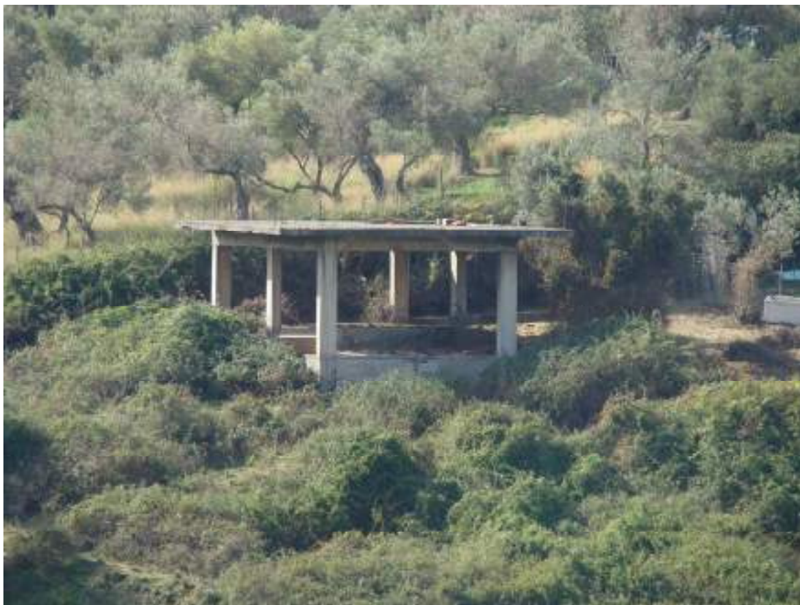
Figura 9 - Fabbricato al rustico
