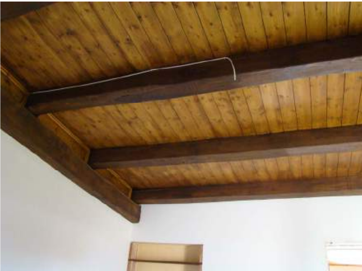
Figura 8 - Particolare soffitto soggiorno e camera da letto matrimoniale
