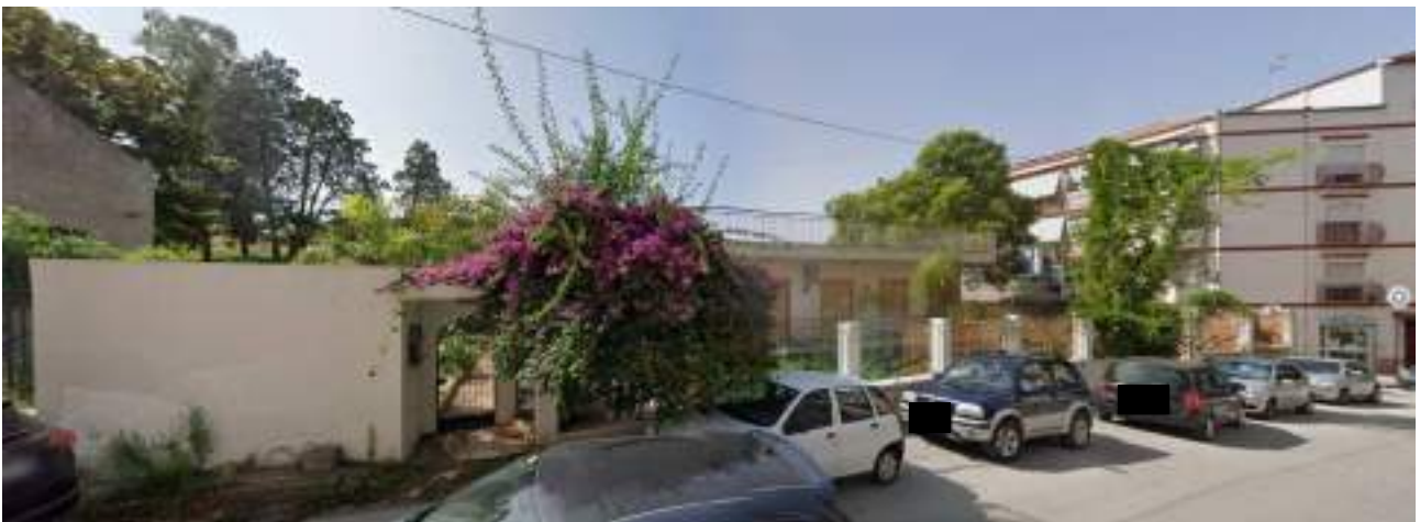
Foto estratta da google maps volo set. 2020 – Ingresso principale
