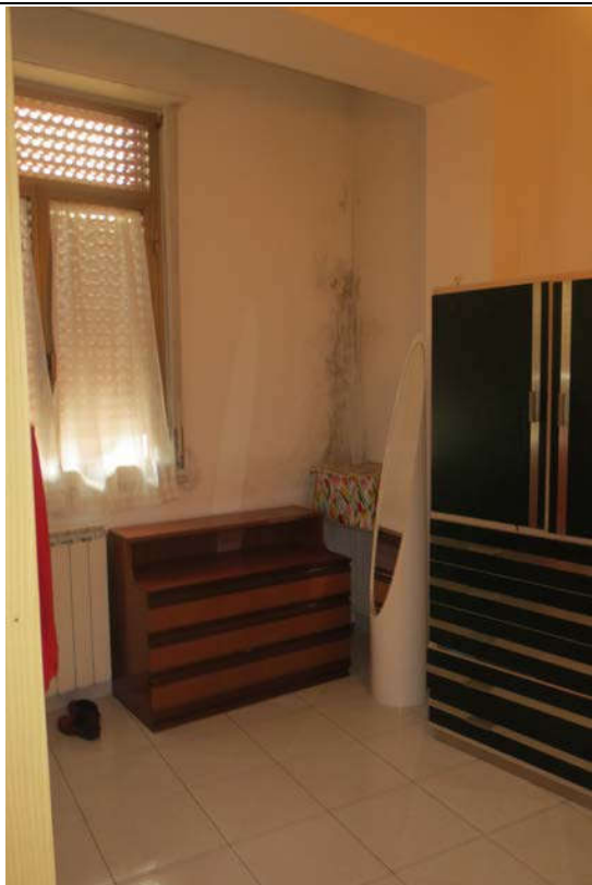
Foto 16 vista della camera singola con evidenti macchie di umidità nella parete esterna
