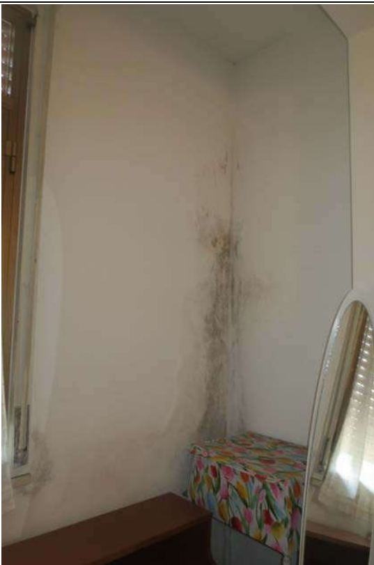
Foto 16 vista della camera singola con evidenti macchie di umidità nella parete esterna
