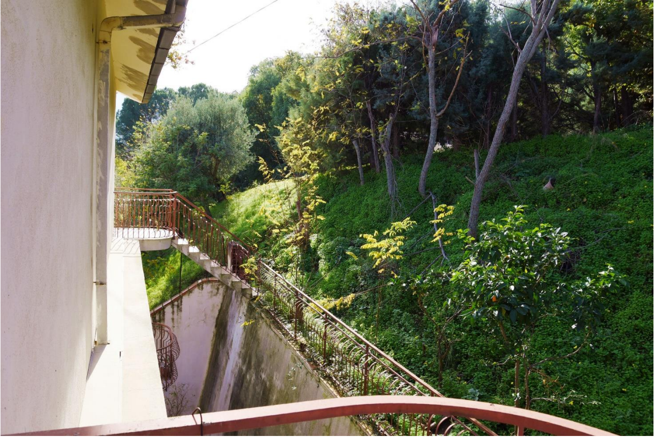
Retro immobile lato ovest vista da balcone lato nord
