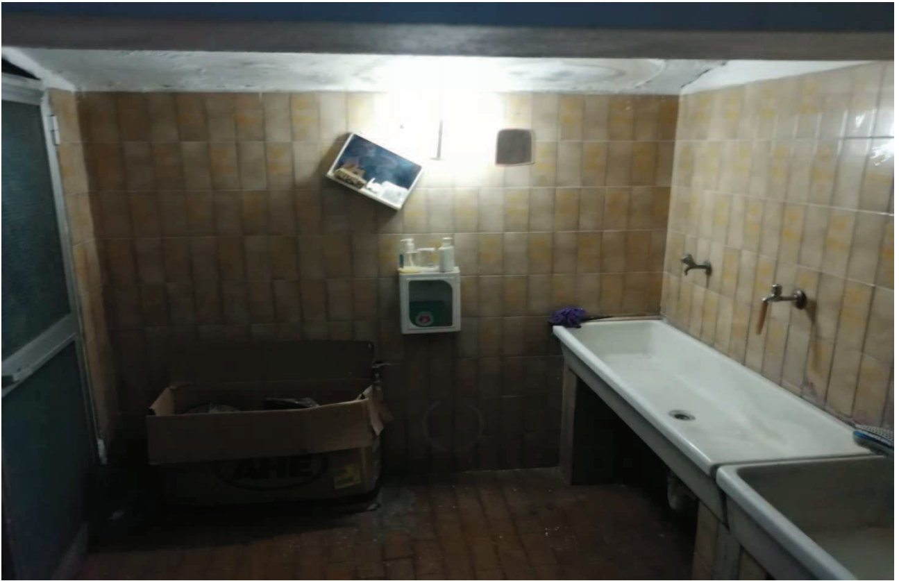
Foto 14- interno wc sotto rampa
