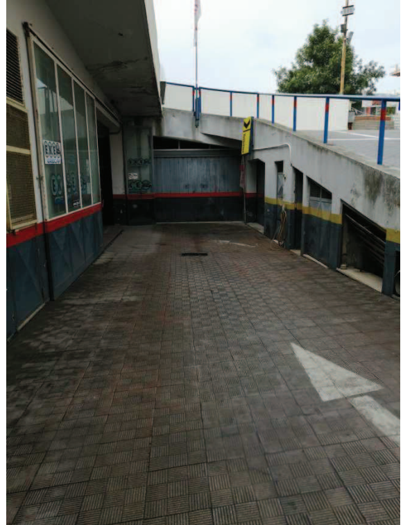
Foto12- vista deposito, wc, autoclave e serbatoi
