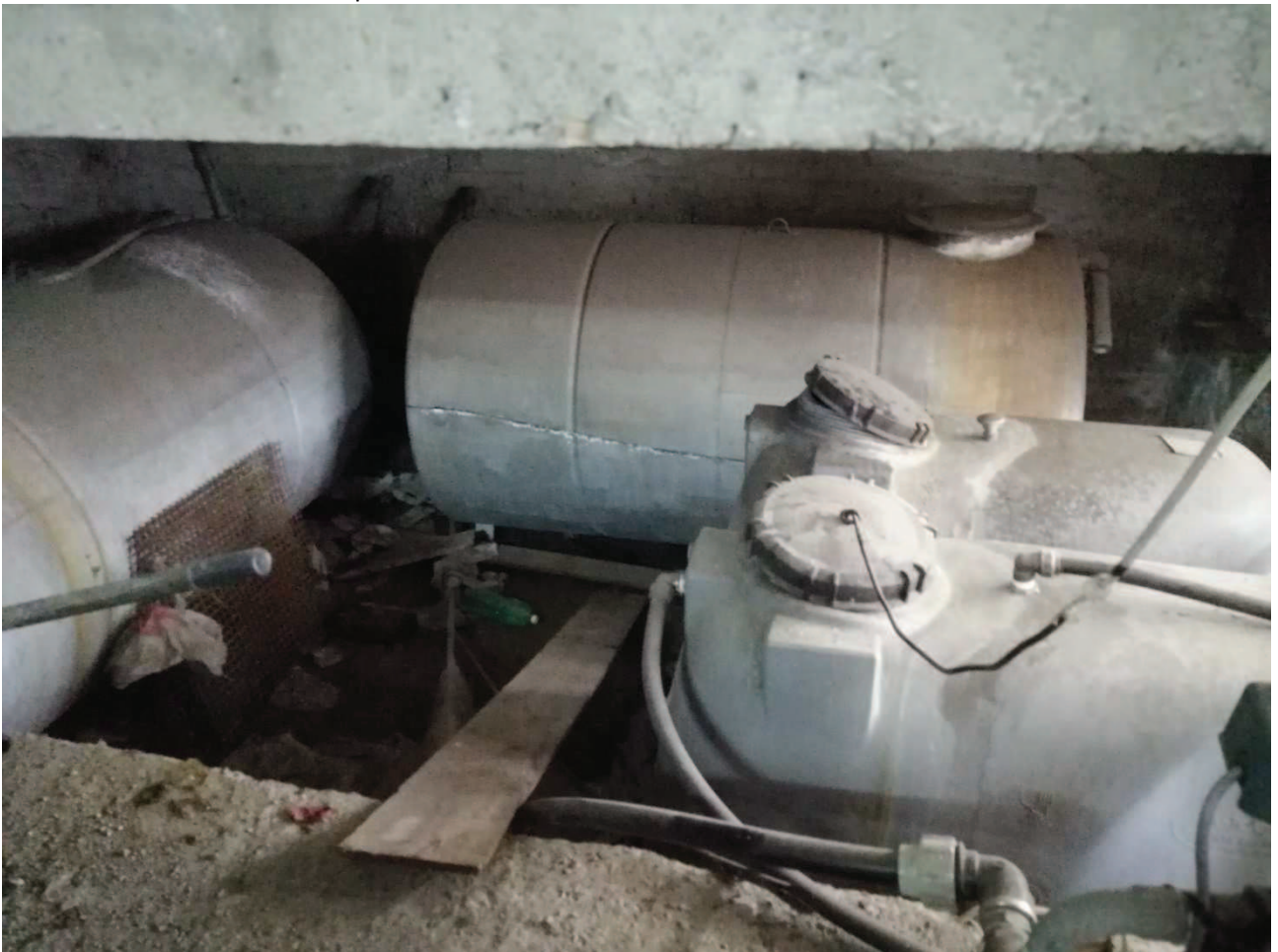
Foto 15- vano serbatoi sotto rampa
