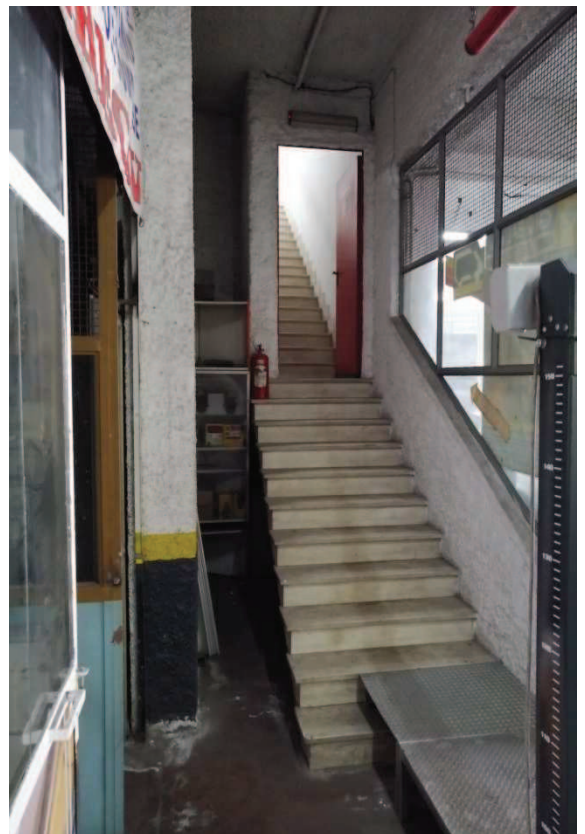
Foto 18- rampa scala di accesso al piano terra
