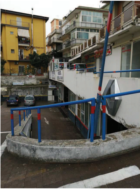
Foto 6- rampa di accesso al cantinato
