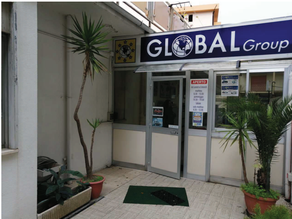
Foto 5 – struttura precaria realizzata in alluminio e vetro con copertura in coibentato.
