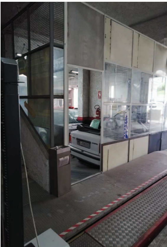
Foto 17- zona interna piano cantinato
