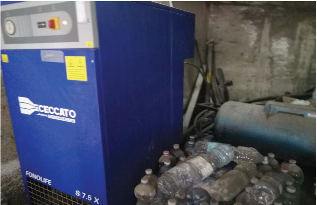
Foto 16- vano autoclave sotto rampa
