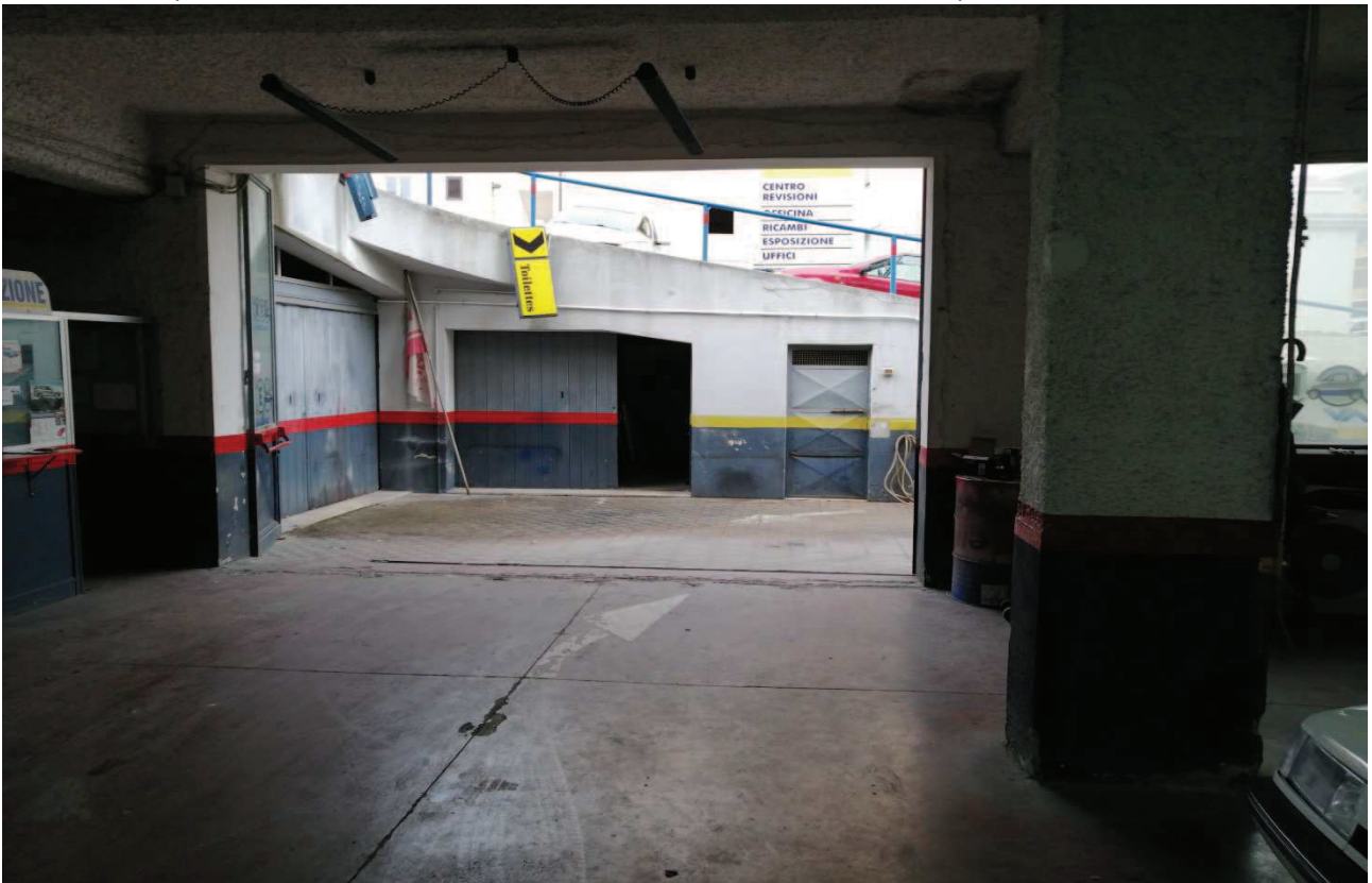
Foto 13- vista dall'interno del magazzino verso l'area deposito e wcsotto rampa
