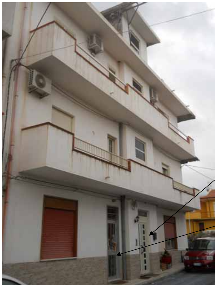
Prospetto principale nord dell'edificio
