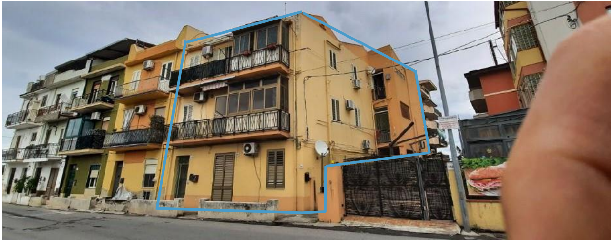
Foto 1: Fabbricato a tre elevazioni fuori terra dove insiste immobile oggetto di perizia
