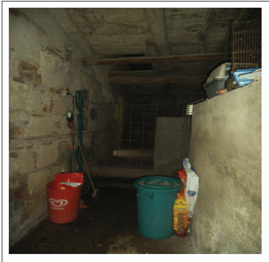
FOTO n° 17 : Interno magazzino – Fg. 1 part. 538 sub 2
