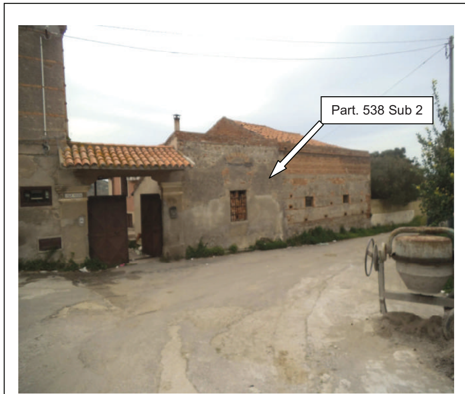
FOTO n° 4 : Prospetto fabbricato (magazzino) oggetto di stima
