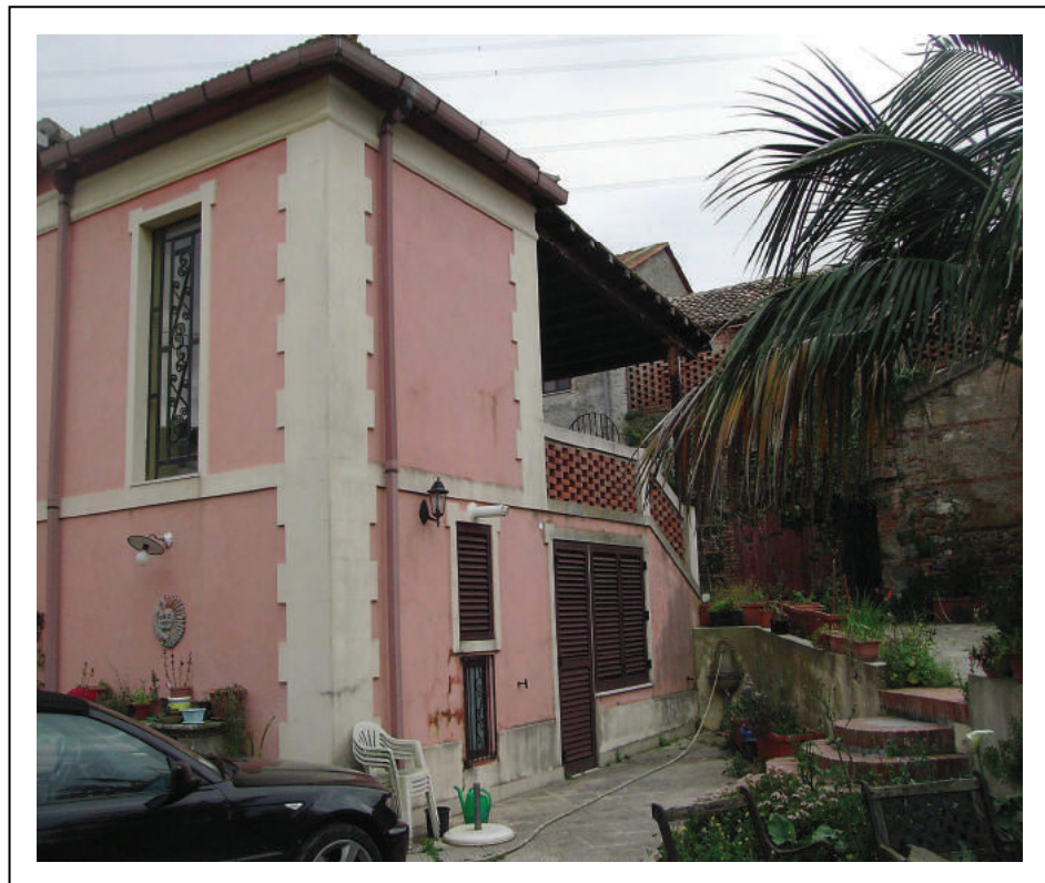
FOTO n° 12 : Prospetto laterale – Fabbr. – Fg. 1 part. 538 sub 1
