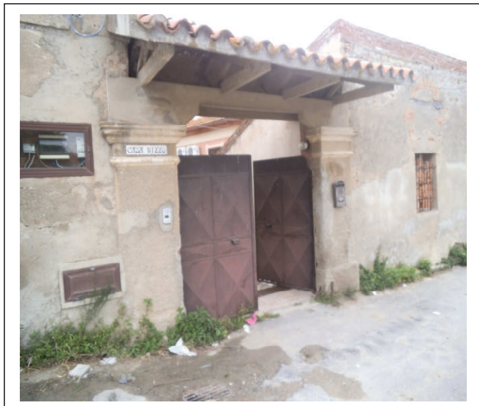
FOTO n° 2 : Portone d' ingresso ai fabbricati oggetto di stima
