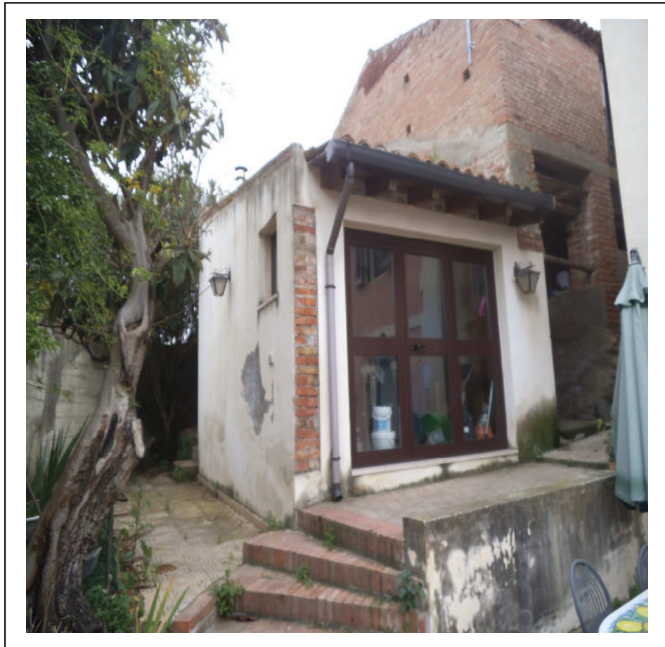
FOTO n° 15 : Vista parziale prospetto magazzino – Fg. 1 part. 538 sub 2
