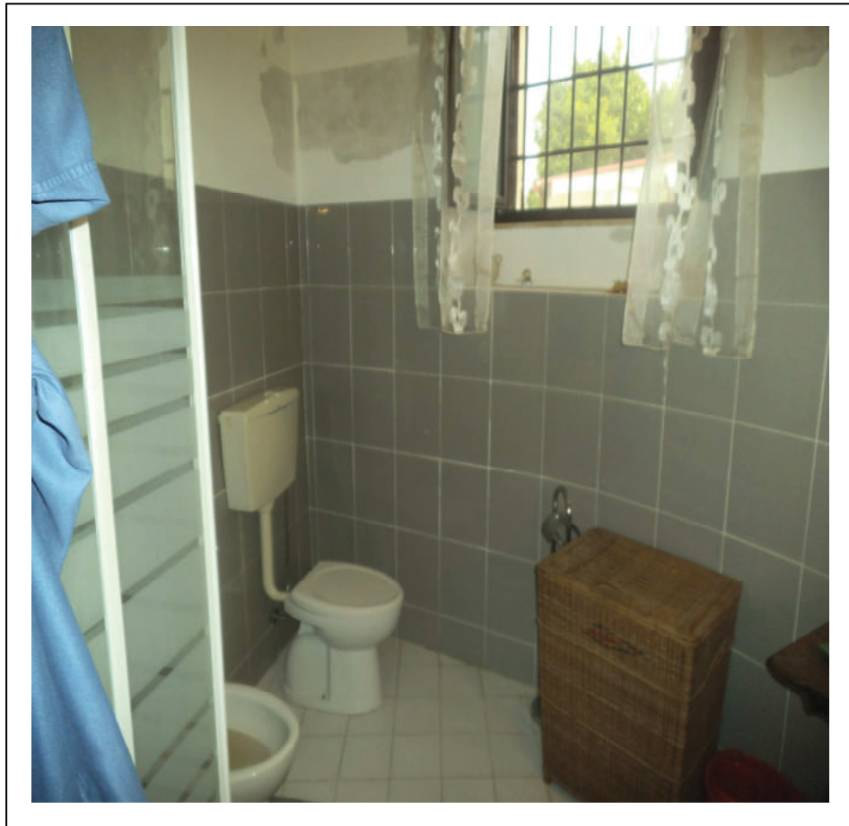
FOTO n° 33 : w.c. - Unità Imm. P.T. - fg. 1 part. 537 sub 1
