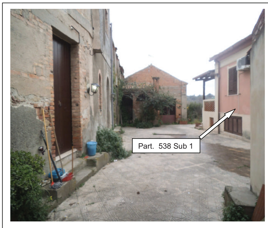
FOTO n° 10 : Fabbricato oggetto di stima
