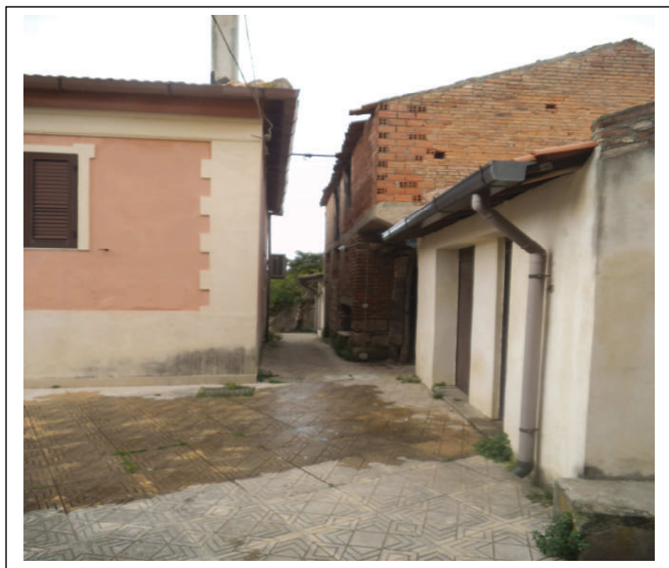
FOTO n° 16 : Vista parziale prospetto magazzino – Fg. 1 part. 538 sub 2
