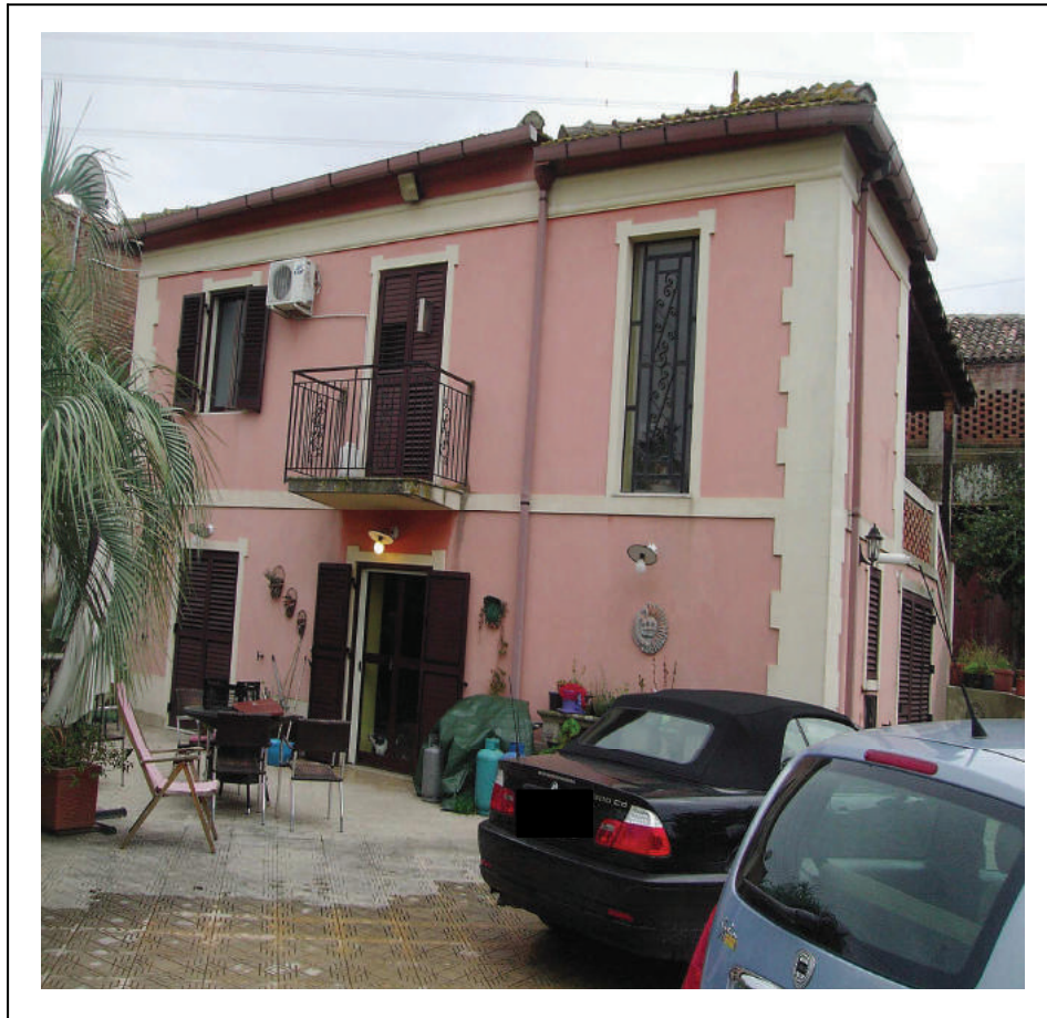
FOTO n° 11 : Prospetto principale – Fabbr. – Fg. 1 part. 538 sub 1
