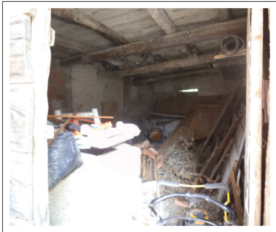
FOTO n° 18 : Interno magazzino – Fg. part. 538 sub 2
