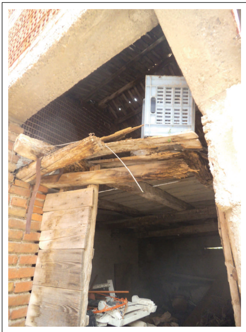
FOTO n° 19 : Parziale veduta interna del magazzino
