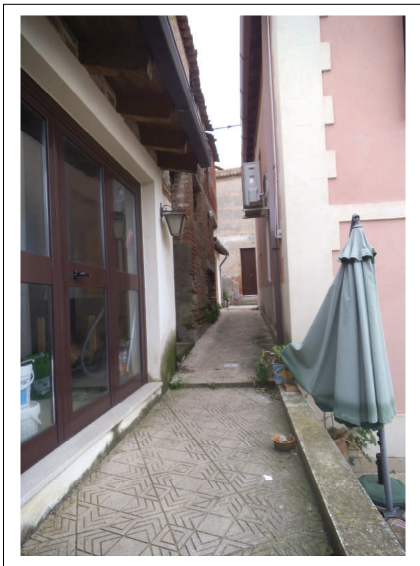
FOTO n° 14 : Vista parziale della corte interna di accesso al magazzino fg 1 part. 538 sub 2
