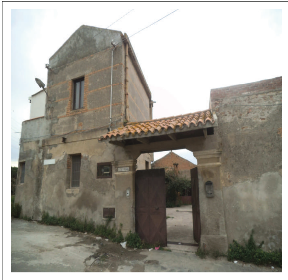
FOTO n° 1 : Portone d'ingresso ai fabbricati oggetto di stima
