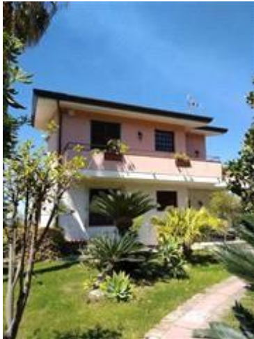
Facciata principale lato strada di accesso vista dal giardino di proprietà.
