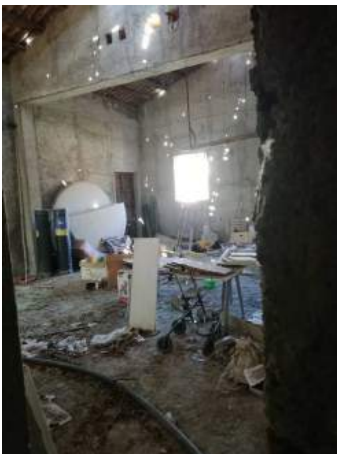
Interno del garage
